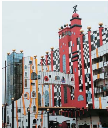
ชื่อ: Incinerator LUMIFLON™: ประเภทตัวทำละลาย วัสดุที่ถูกเคลือบ: คอนกรีต
