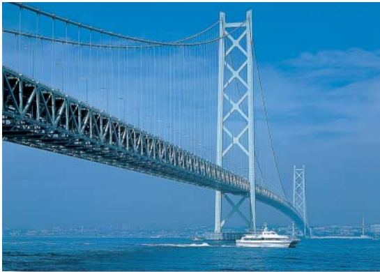
ชื่อ: สะพานอะคาชิ สเตรท LUMIFLON™: ชนิดตัวทำละลาย วัสดุที่ถูกเคลือบ: เหล็ก
