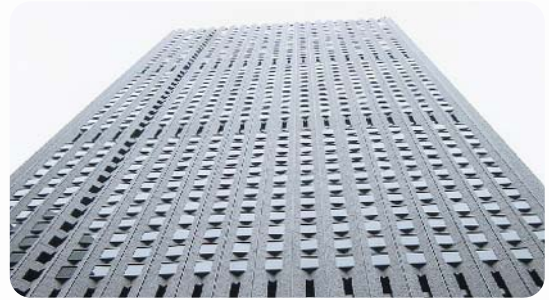
ชื่อ: อาคารชินจูกุ เซ็นเตอร์ LUMIFLON™: อิ้มัลชั่น (การทาสีทับ) วัสดุที่ถูกเคลือบ: คอนกรีต
