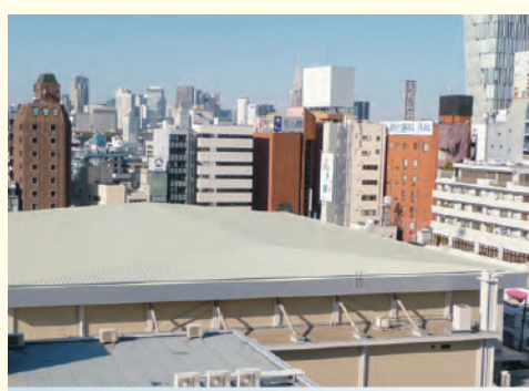
大学体育館 屋根(2010年施工)
