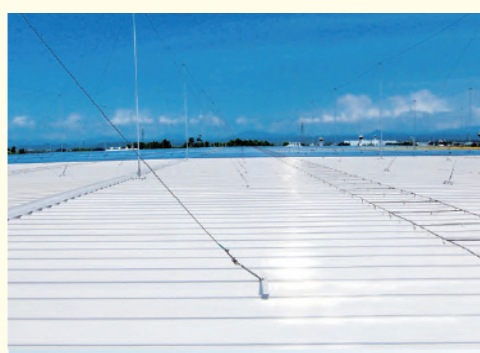
工場 折板屋根(2010年施工)
