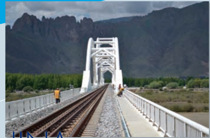
ラサ川橋(ラサ市)
