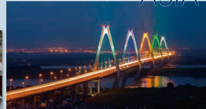
ニャットン橋 (ベトナム)
