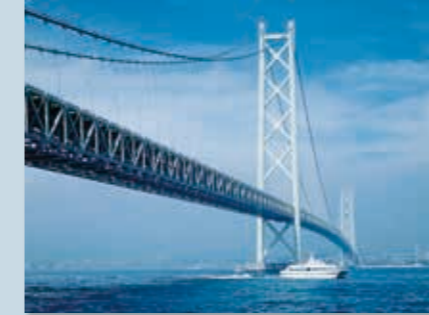
明石海峡大橋(兵庫県)
