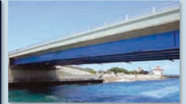
Boynton Inlet Bridge(フロリダ州)
