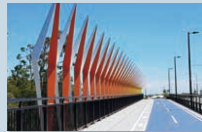
Aura Boulevard Bridge(オーストラリア)
