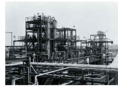
④ 千葉工場のフロンプラント
