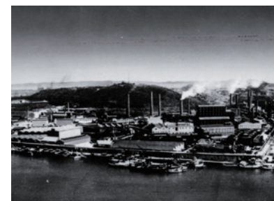
① 北九州の牧山工場全景
