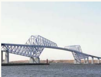
東京ゲートブリッジ
