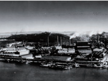
① 北九州の牧山工場全景
