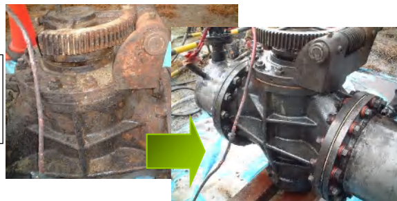
図6：実施例2 塗装下地処理 (圧力0.5MPa、EB-60)
