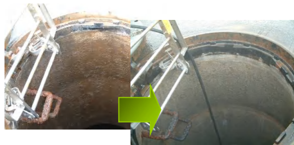
図7：実施例3 コンクリート錆汁洗浄 (圧力0.5MPa、EB-60)
