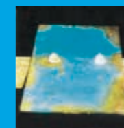
塩化ゴム塗料 コーナー部に錆
