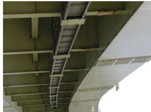
添接部に一部錆が発生しています。
