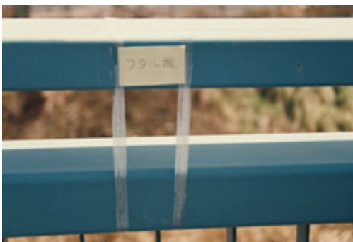
フタル酸部分：チョーキングが発生しています。
