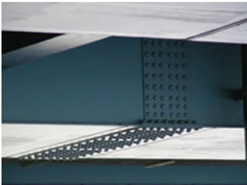
添接部の一部にわずかに発錆が見られました。
