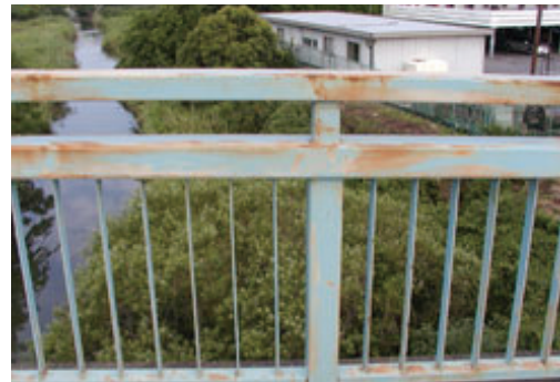
上塗り、中塗りが消失、下塗りと錆も出始めてい ます。
