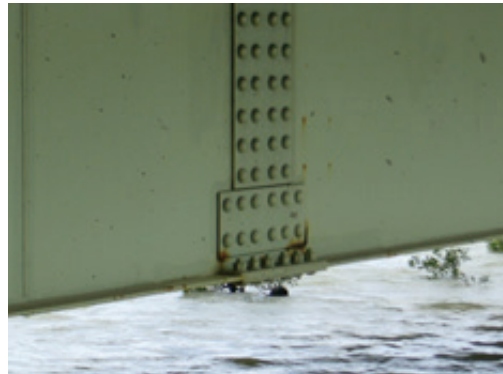
ポリウレタン：一部錆が発生しています。
